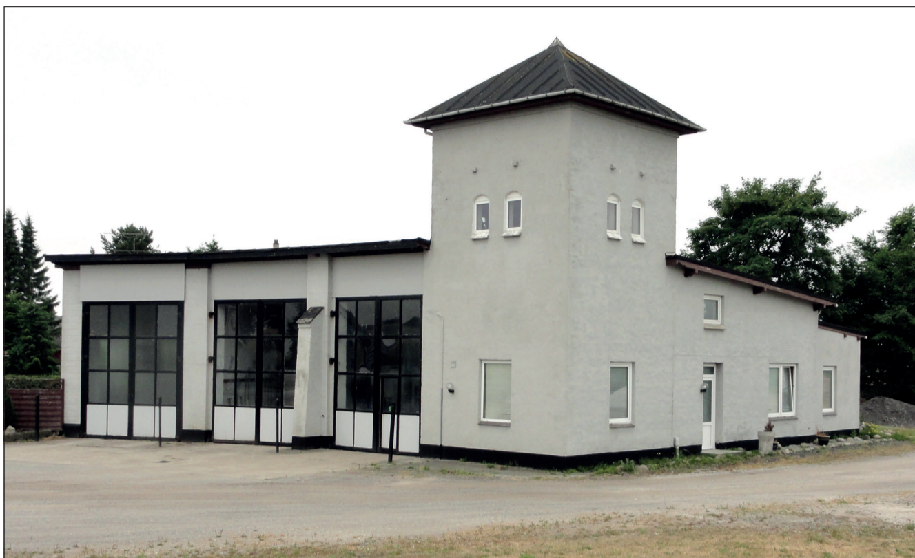
Vodskovbanens lokomotivremise på hjørnet af Brønderslevvej og Møllegade. I tårnet var indbygget en vandbeholder, hvorfra lokomotivernes vandtanke blev fyldt; et tilsvarende tårn findes på banens remise i Vodskov. Lokomotiverne kørte ind i remisen via en drejeskive, som efter sigende stadig skal ligge under forpladsens grus.
