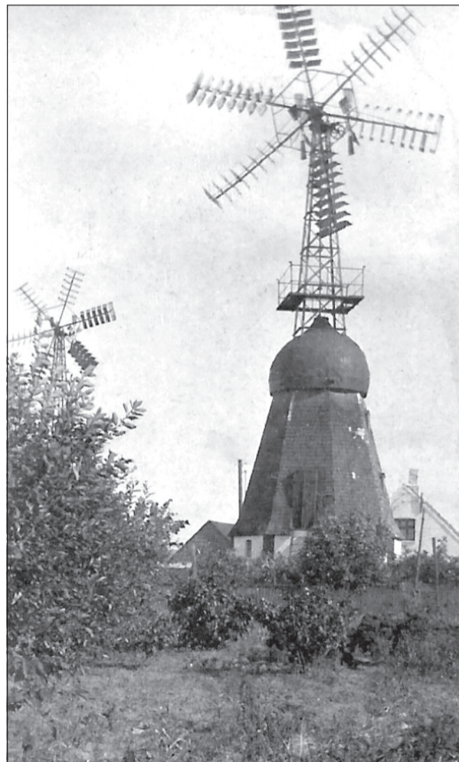
To klapsejlere eller vindmotorer: den til venstre i billedkanten er vandværkets, som pumpede vandet fra borerne op i vandbeholderen på Møllergaards Bakke. Klapsejleren i midten af billedet blev i 1926 bygget ovenpå den gamle hollandske mølle for at komme højere op og fange vinden; den blev fortsat benyttet til kornmaling. Billedet formentlig fra kort efter 1926.
