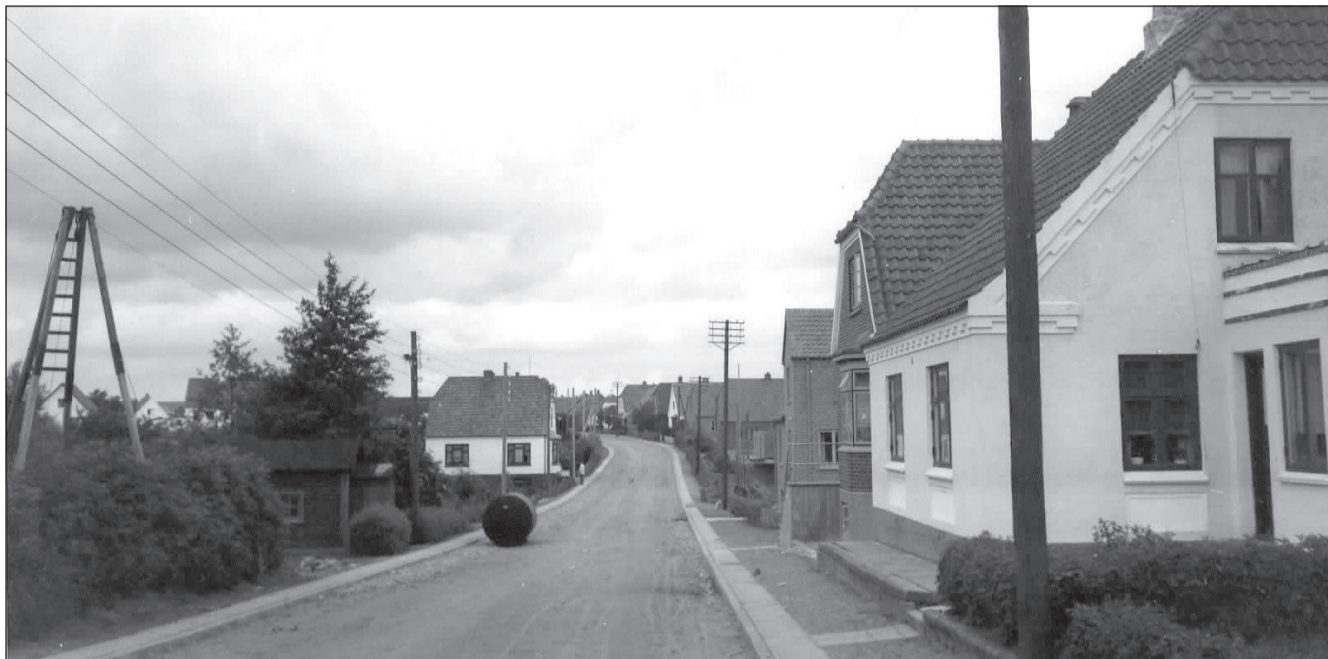
Møllegade, vist omkring 1946. I gadens venstre side ses det oprindelige pumpehus; bag dette ses, hvad der formentlig er en igangværende boring. – Fortovet har fået en enkelt række fliser, men gaden er tilsyneladende endnu ikke asfalteret. Bemærk også her el- og telefonledningerne.
